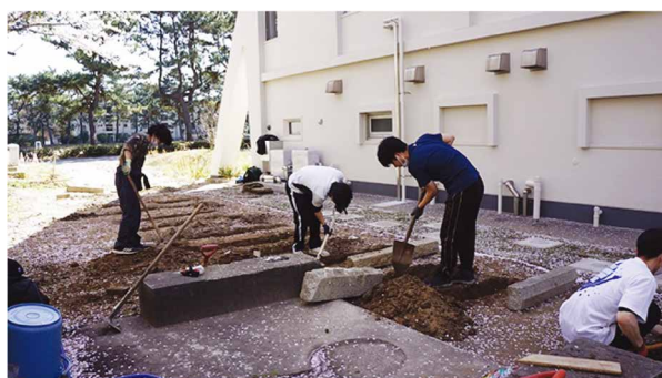
図13 学生参加による敷石の設置
