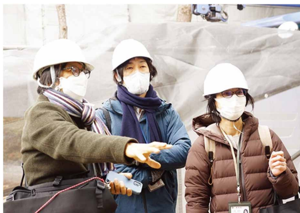
図29 GYMLABO改修現場での打ち合わせ
