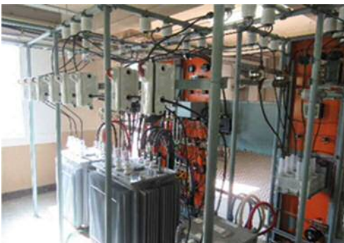
【受配電室変圧器老朽化状況（経年 33 年）】
