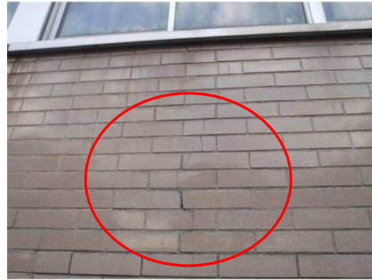
老朽施設の外壁（経年 59 年）
