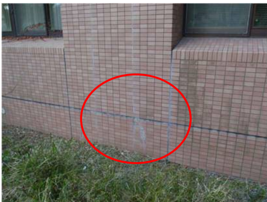
老朽施設の外壁（経年 26 年）
