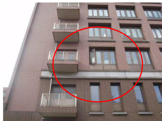
老朽施設の外壁（経年 24 年）
