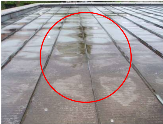
老朽施設の金属屋根（経年 23 年）
