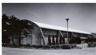
改修前の旧体育館
