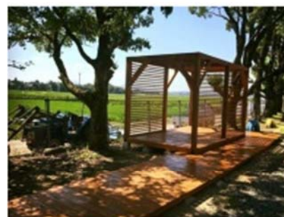
東屋と木製デッキテラス完成!
