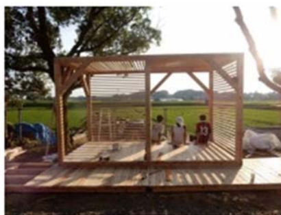
東屋と木製デッキテラスの施工の様子
