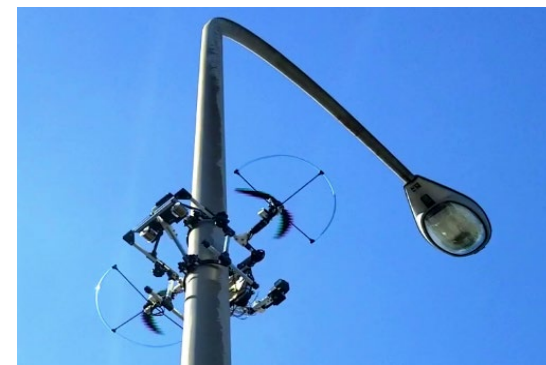
新型ロボットによる高所点検
