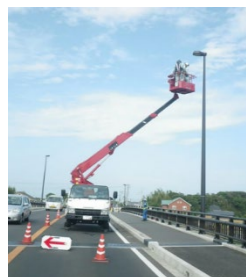
(従来) 高所作業車による点検
